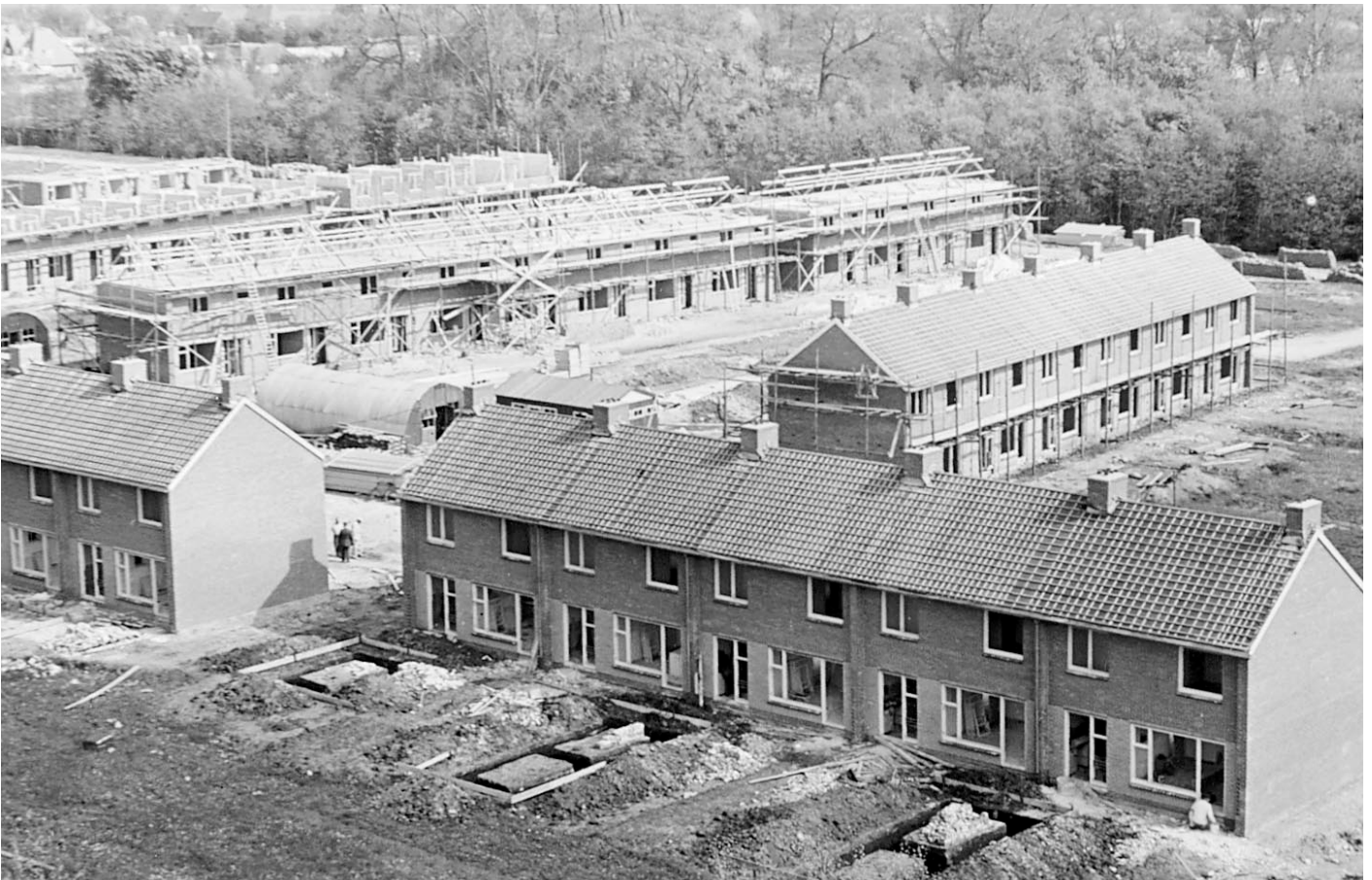
Philipswoningen Type A in de Swetten in aanbouw, 1955 (Derks, 2000)
