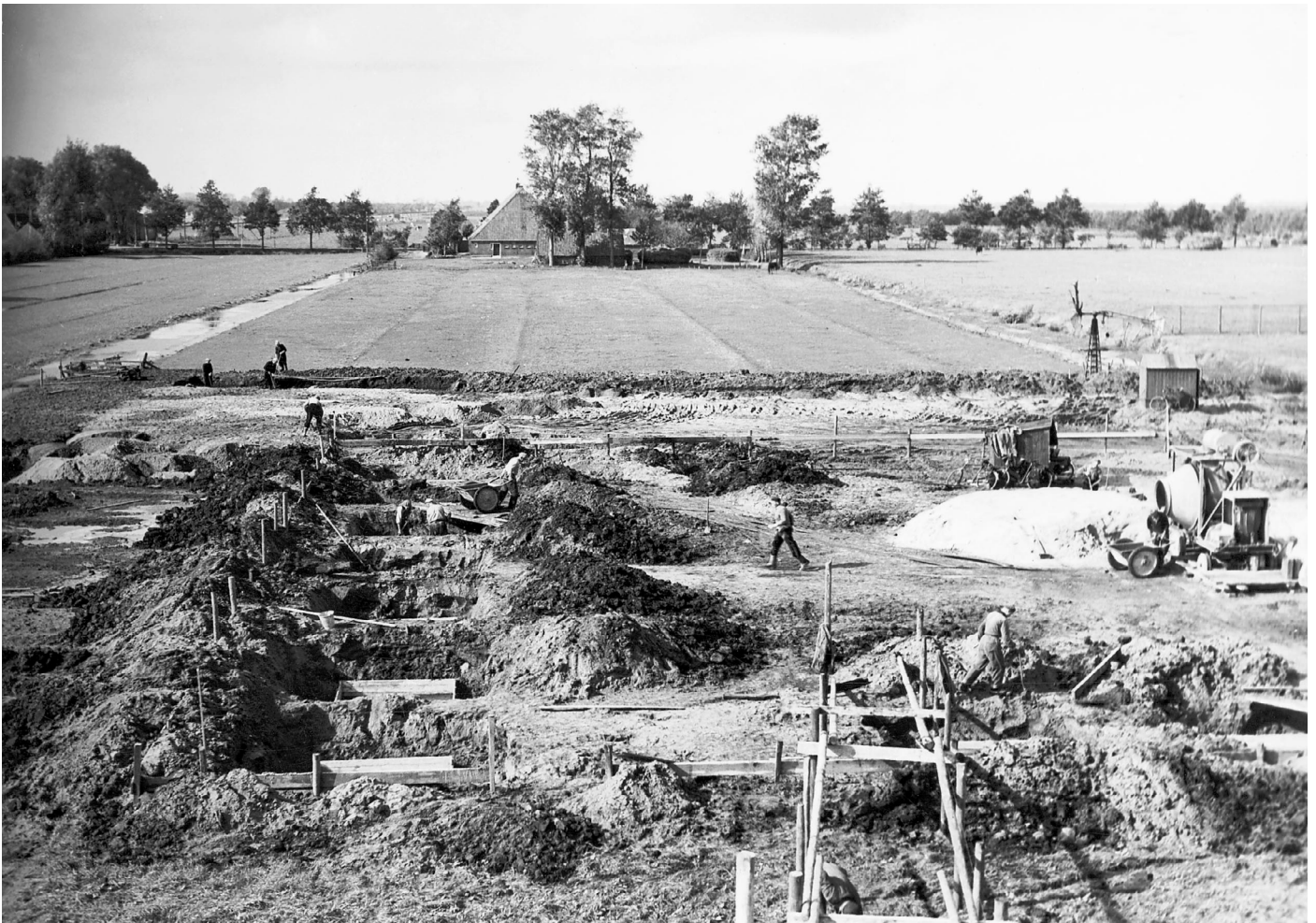
Start constructie eerste gebouwen voor Philips (Derks, 2000)
